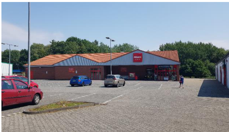
Abbildung 33: Penny-Parkplatz im Gewerbegebiet Notscheider Straße
