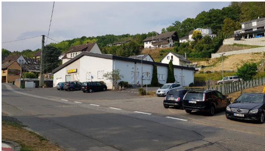
Abbildung 35: Parkplätze am Bürgerhaus Kasbach-Ohlenberg
