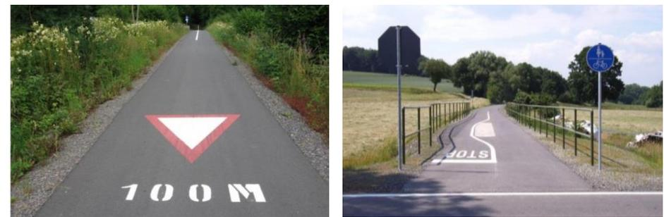
Abbildung 12: Beispiele für die Markierung von Kreuzungen
